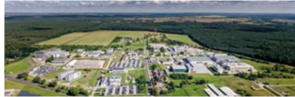
TEW Technik-Energie-Wasser Servicegesellschaft mbH im BioPharmaPark Dessau
